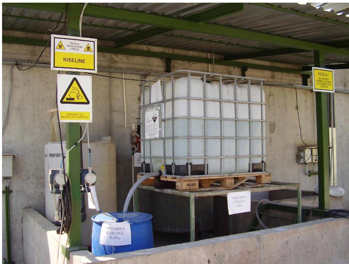
Slika 7. – Rezervoar sa fosfornom kiselinom
