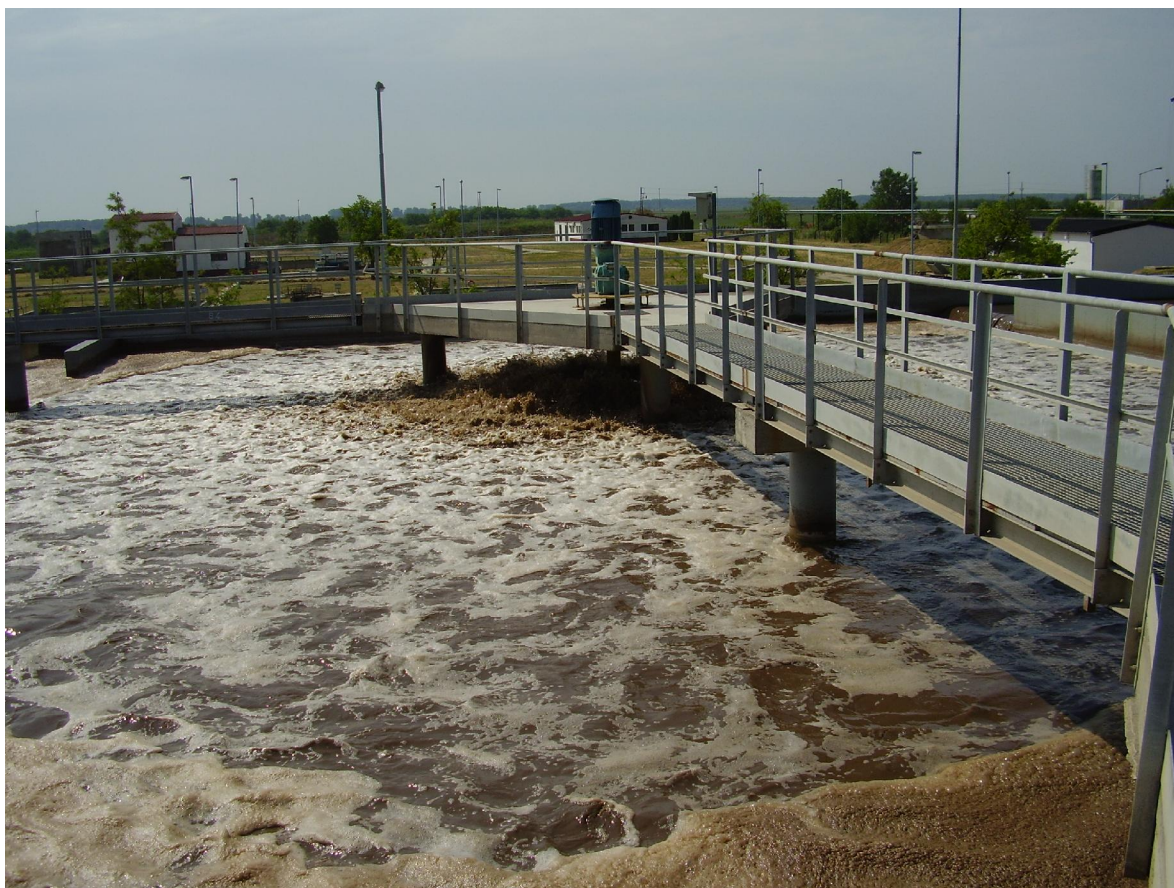
Slika 5. – Bazen za oksidaciju
