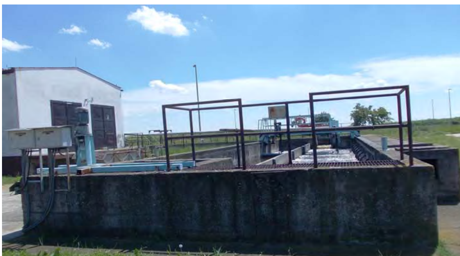
Песколов са сепаратором масноће
