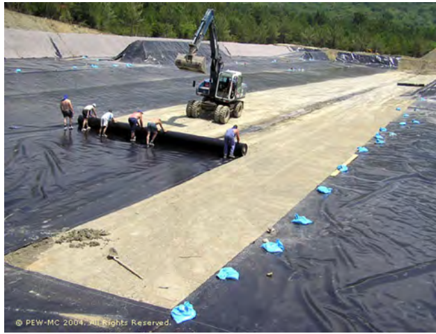
A szanitáris hulladéklerakó szigetelése HDPE fóliával
