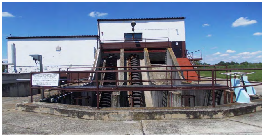
Csigaszivattyús szivattyúállomás
